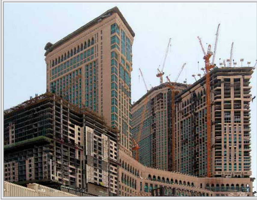
■ Ecyâd Kalesi yerine inşa edilmekte olan otel kompleksi
