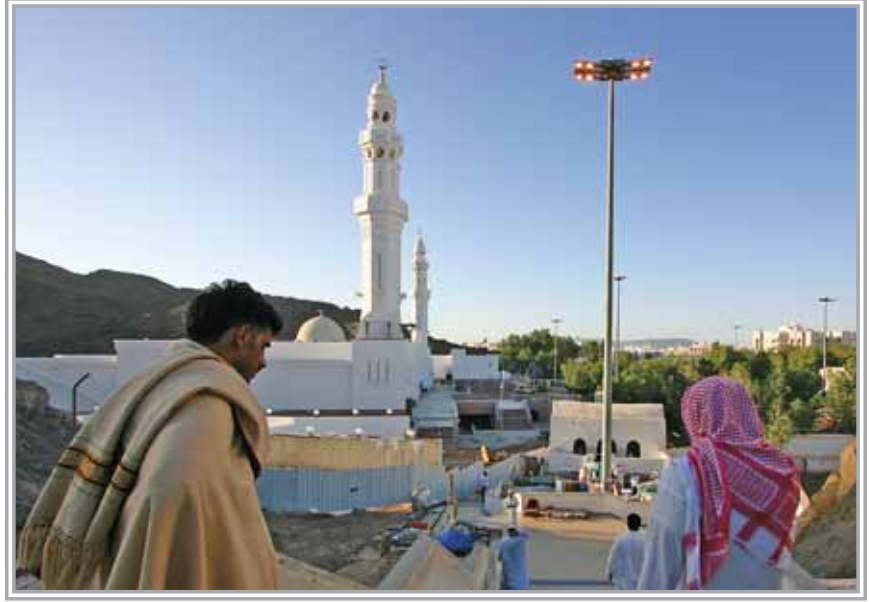
■ Mescid-i Feth'in önünden, Mescid-i Selmân el-Fârisî ve diğer mescidlerin yerine inşa edilen yeni caminin görünüşü
